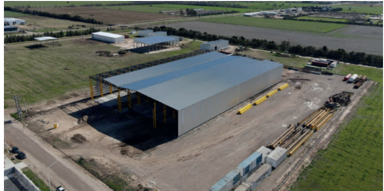
La nueva nave lista para darle mayor comodidad a la producción de equipos petroleros
